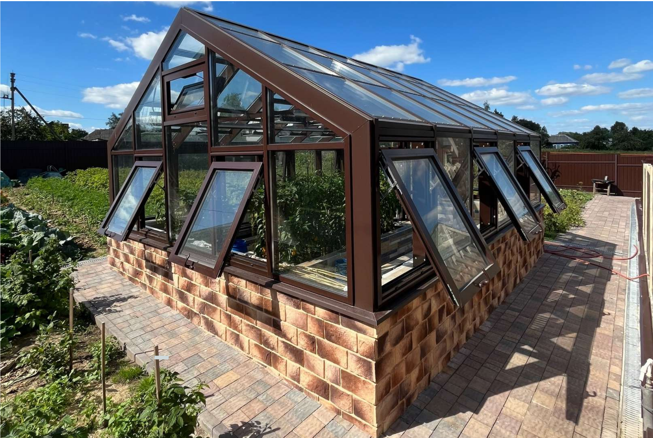
Теплица, г. Белгород Оконно-дверная серия с терморазрывом Алнео ALT 65 . Фасадная серия Алнео ALF 50 , Серия верхнеподвесных окон Алнео ALT83 .
