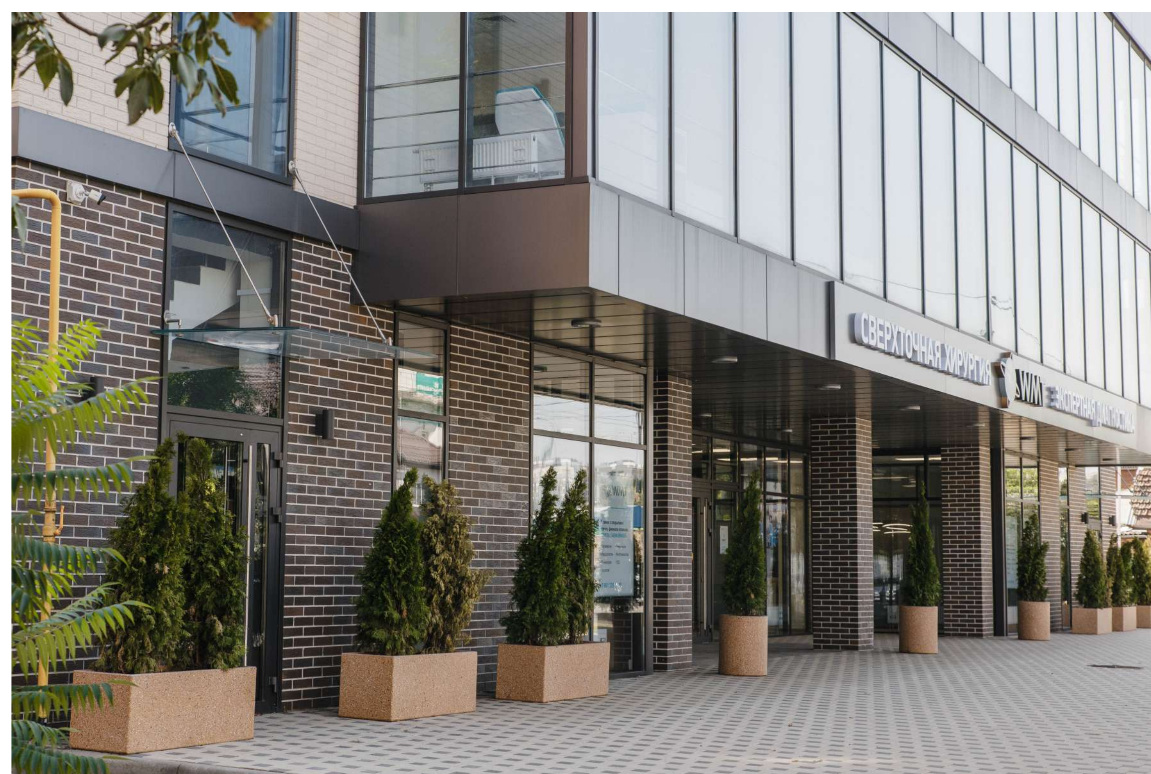
Медицинский центр, г. Краснодар Оконно-дверная серия с терморазрывом Алнео ALT 65 . Фасадная серия Алнео ALF 50
