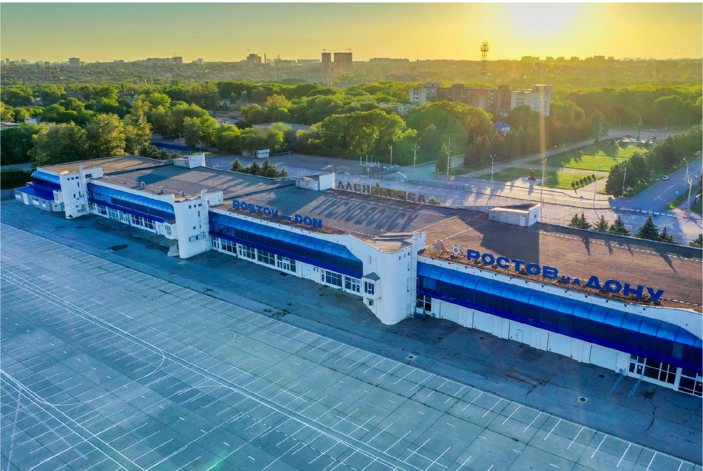
Аэропорт, г. Ростов-на-Дону. Оконно-дверная серия с терморазрывом Алнео ALT 65 . Фасадная серия Алнео ALF 50 .
