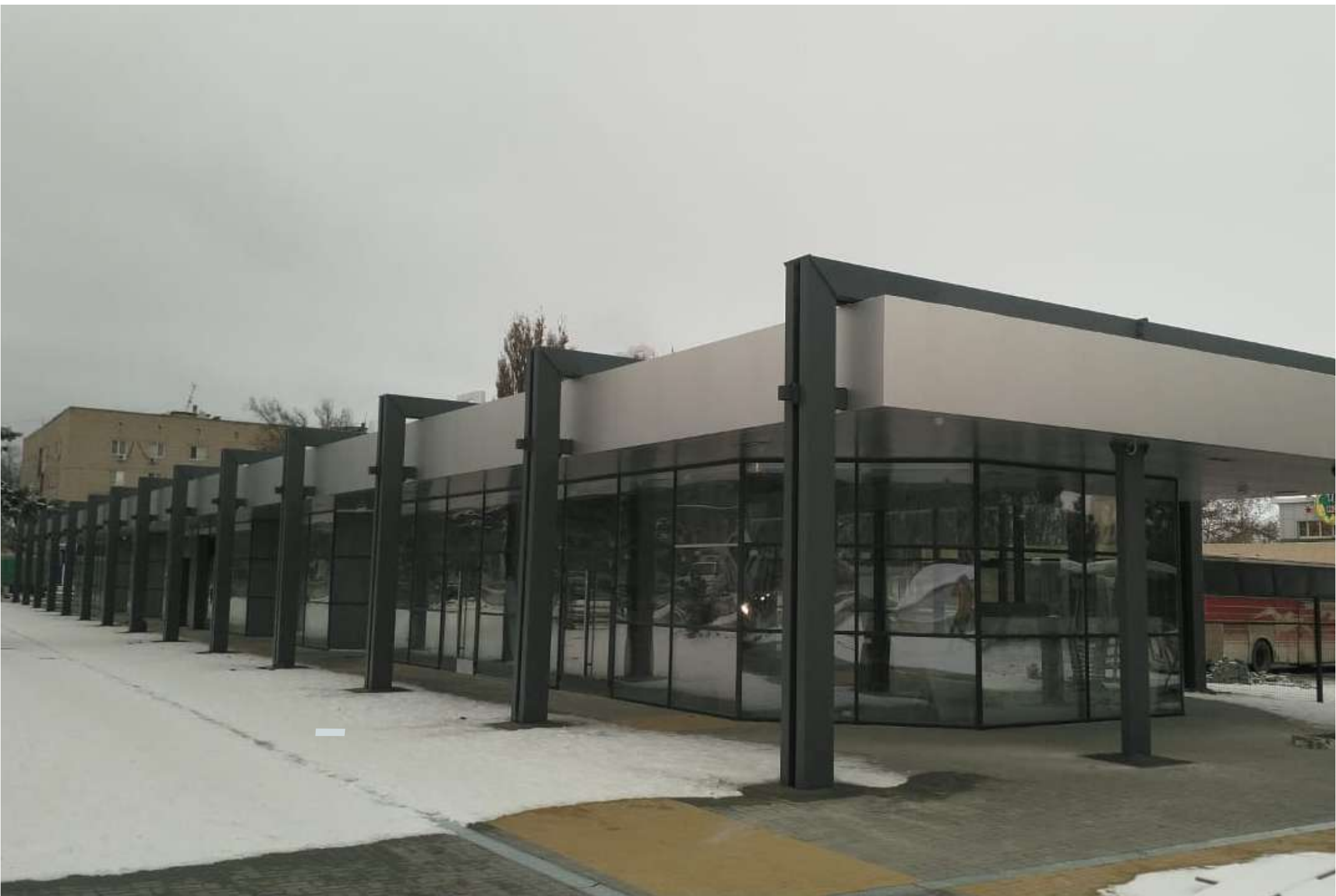
Торговый комплекс, Ростовская обл. Оконно-дверная серия с терморазрывом Алнео ALT 65 . Фасадная серия Алнео ALF 50 .
