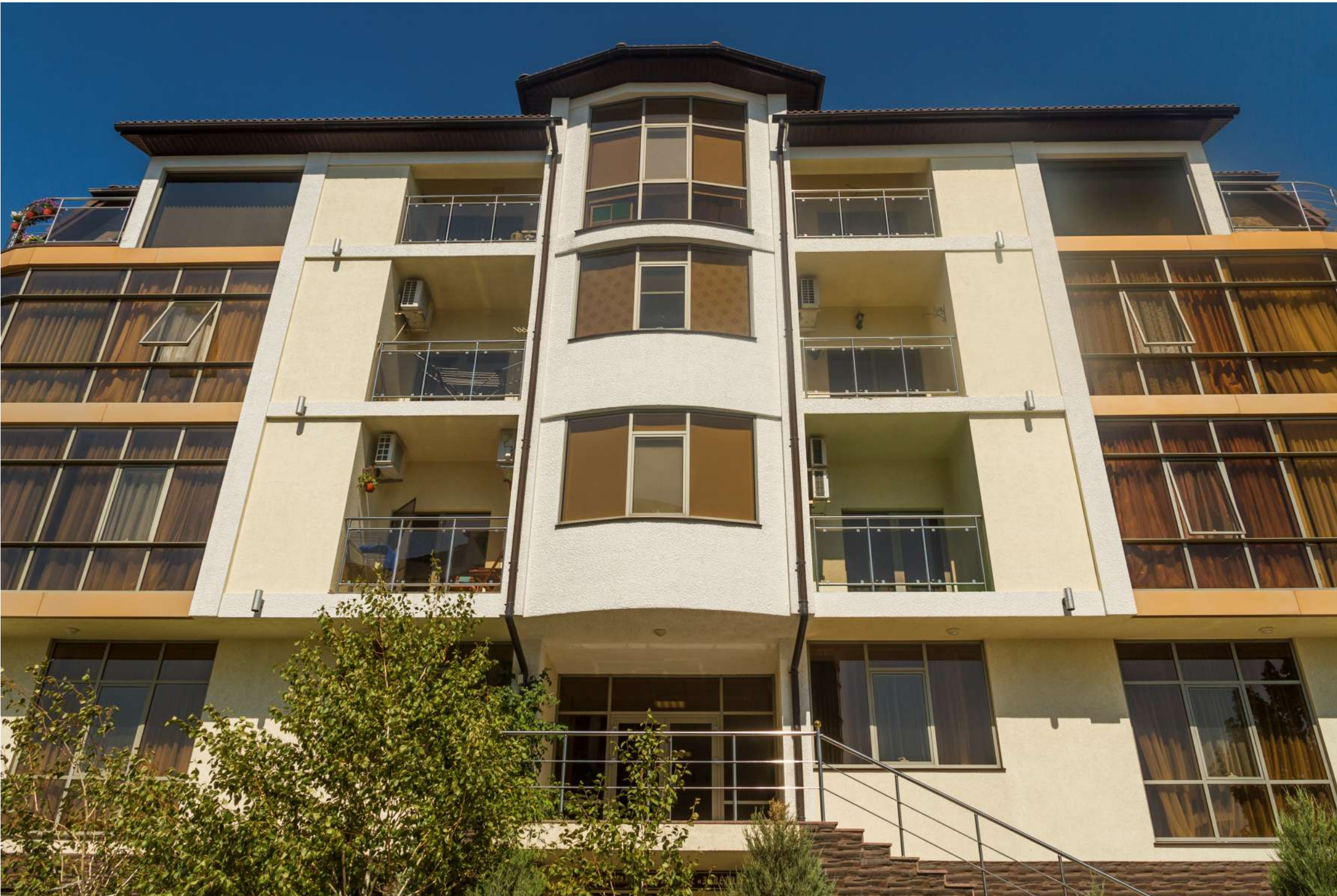
ЖК «Заветный» г. Новороссийск, с. Мысхако, ул. Заветная, 65. Оконно-дверная серия с терморазрывом Алнео ALT 65 . Фасадная серия Алнео ALF 50 .
