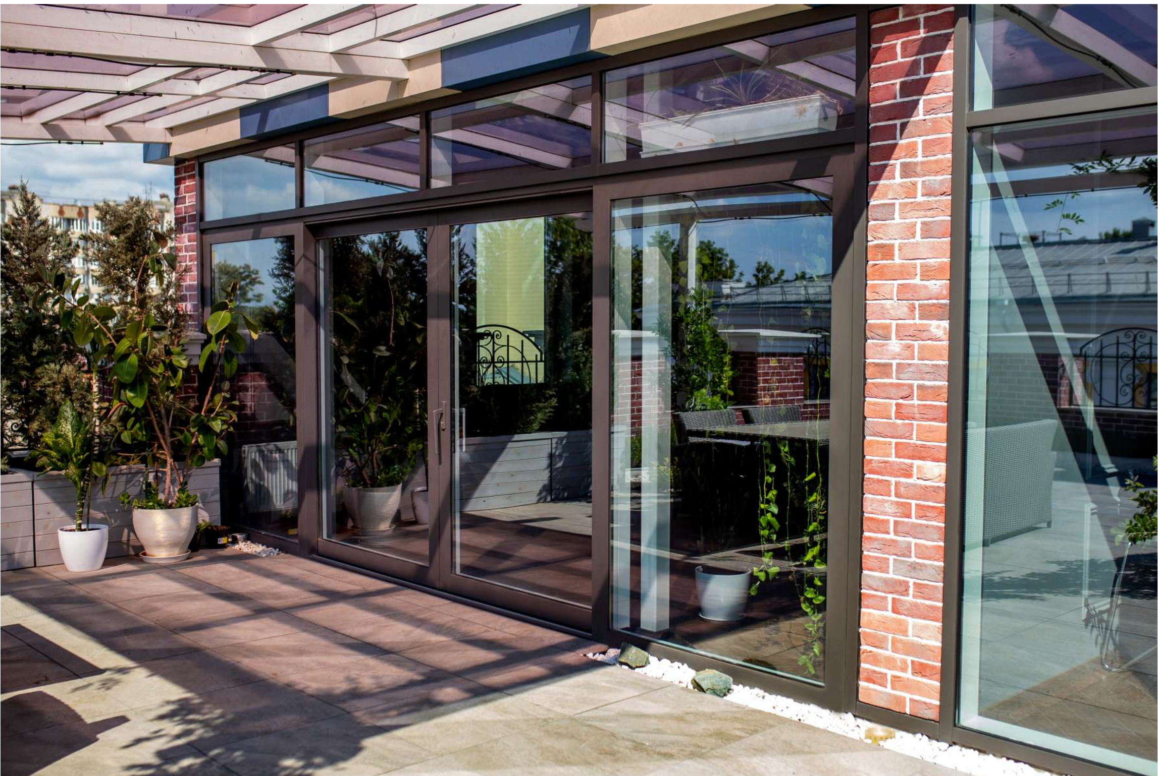
Офисное здание. г. Краснодар. Подъемно-сдвижная серия с терморазрывом Алнео ALR 72 . Фасадная серия Алнео ALF 50 .
