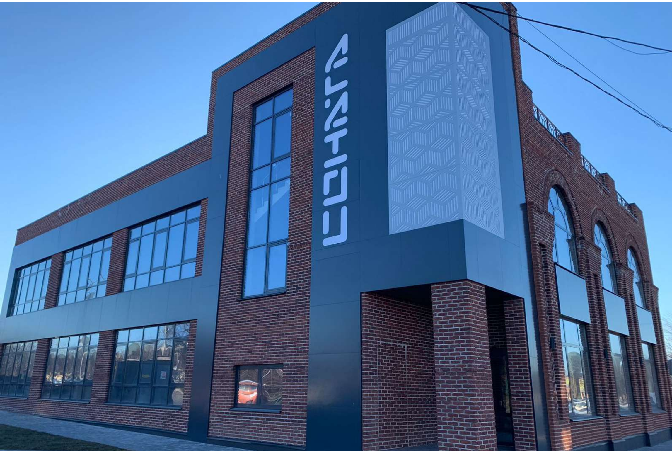
Строительный объект, г. Ростов-на-Дону. Оконно-дверная серия с терморазрывом Алнео ALT 65 . Фасадная серия Алнео ALF 50
