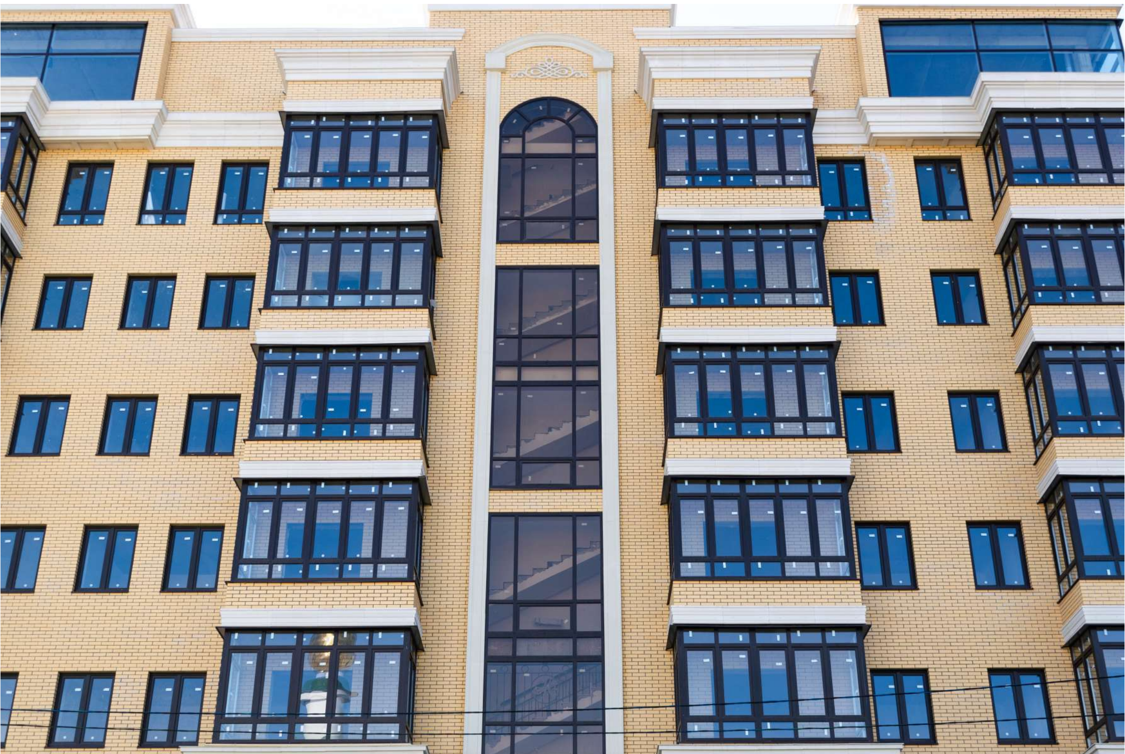
ЖК, г. Армавир, ул. Комсомольская, д.106. Оконно-дверная серия с терморазрывом Алнео ALT 65 . Фасадная серия Алнео ALF 50 .
